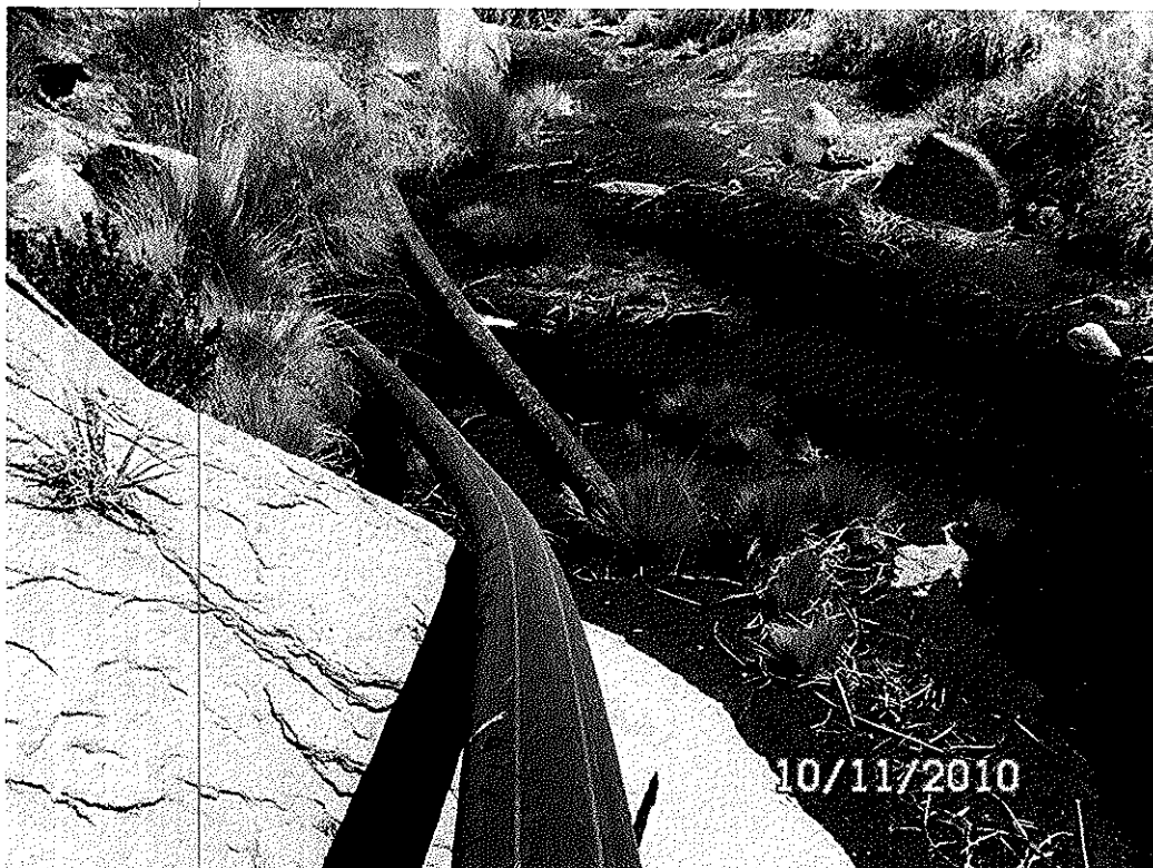
Fotografía N° 13. Discontinuidad en la línea de tuberías, sector Quebrada Honda
