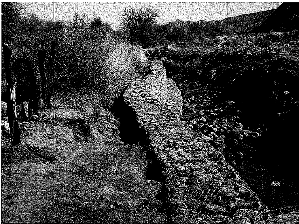
Fotografía N° 2. Frente de trabajo en ayllu de Catarpe
