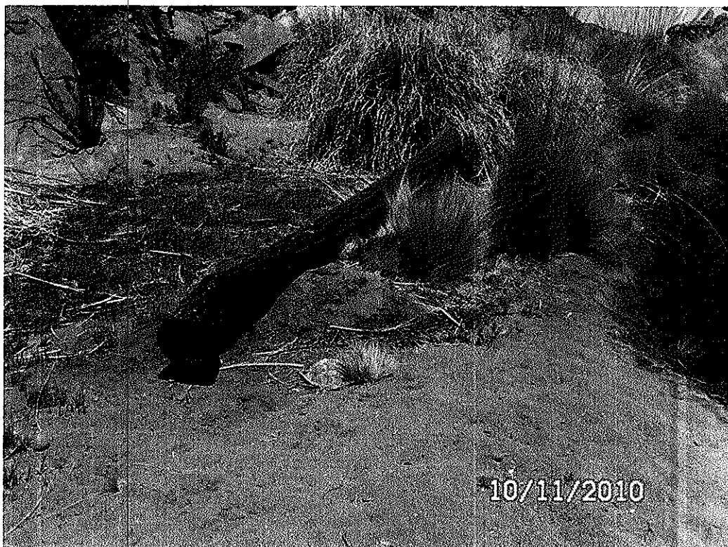
Fotografía N° 12. Tubería defectuosa, sector Quebrada Honda
