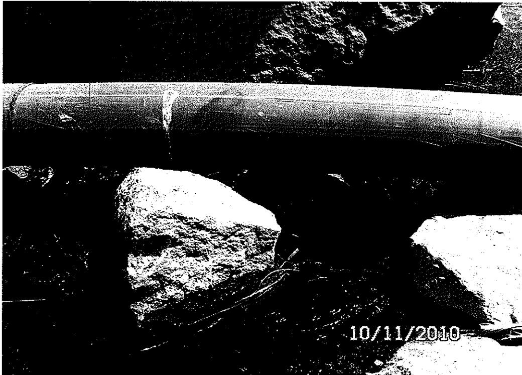
Fotografía N° 7. Apoyo de tubería
