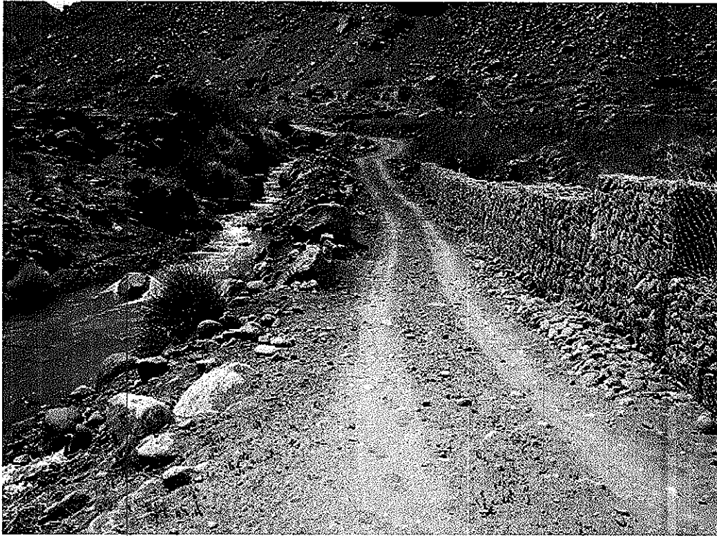
Fotografía N° 1. Frente de trabajo de Río Grande, continuación de faenas anteriores
