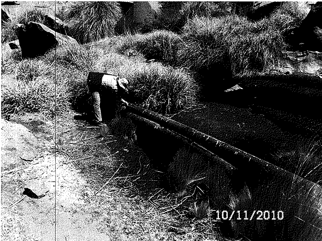
Fotografía N° 10. Tuberías traslapadas, sector Quebrada Honda
