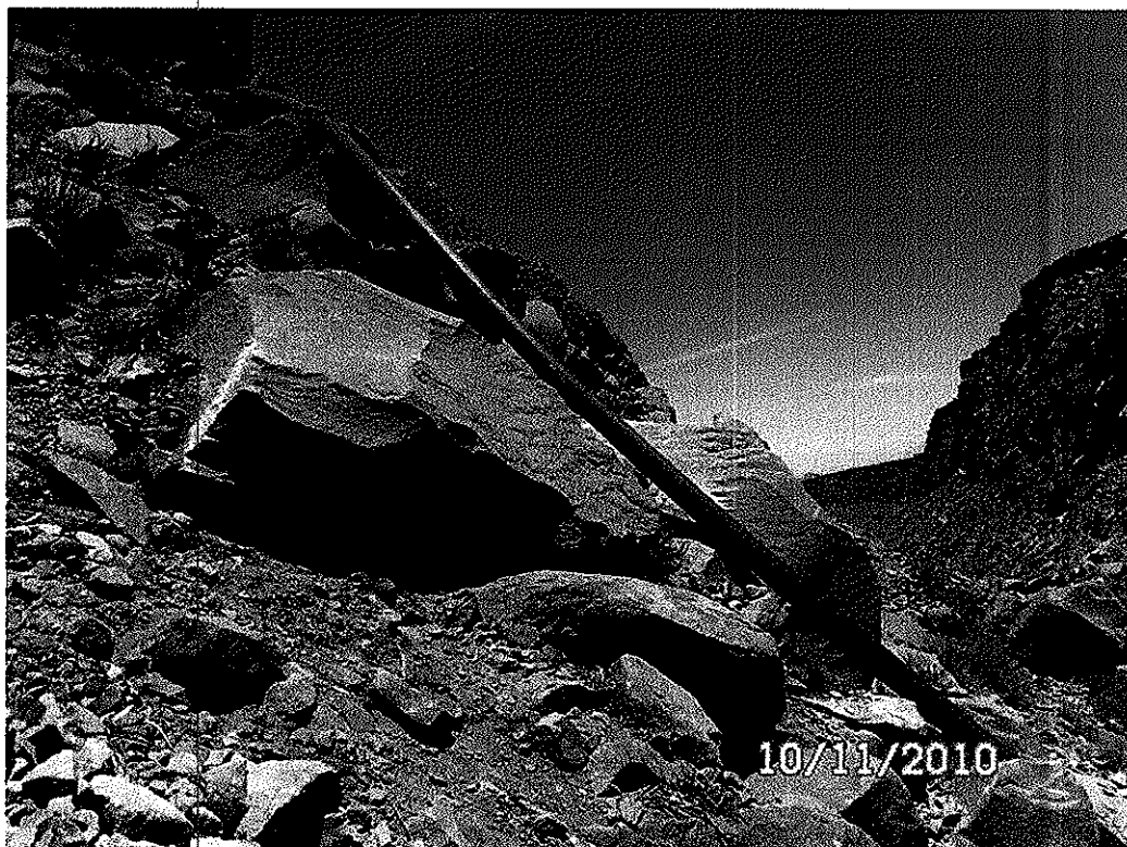
Fotografía N° 14. Tubería no instalada, sector Quebrada Honda
